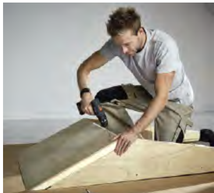
1. Assembler les éléments isolants compris dans la livraison.
