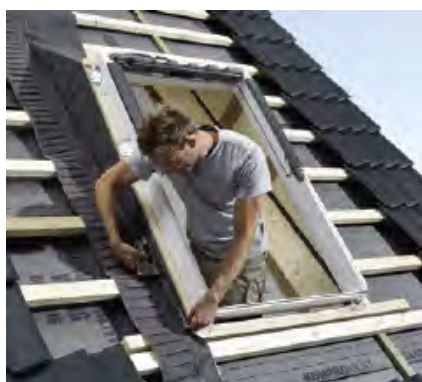
4. Monter le raccord de sous-toiture BFX fourni pour réaliser un raccordement étanche à la pluie.
