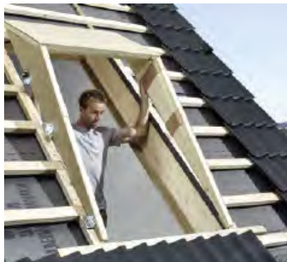
2. Poser les éléments isolants sur la découpe du toit préparée et les relier à la sous-structure.
